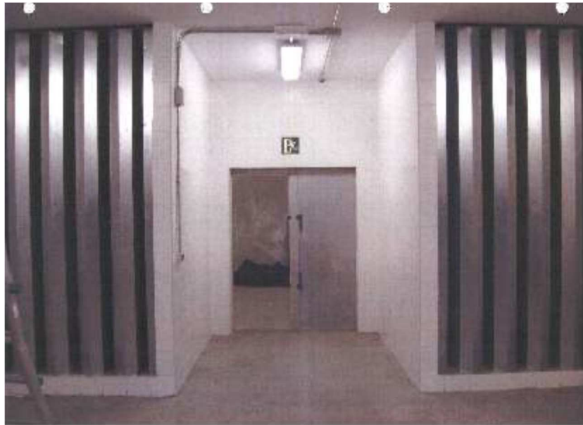
Figura 9. Silenciadores de bafles paralelos
